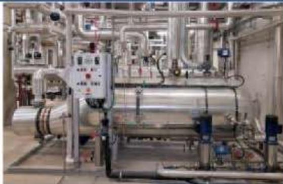
Figura 1 – Generatore di vapore pulito
